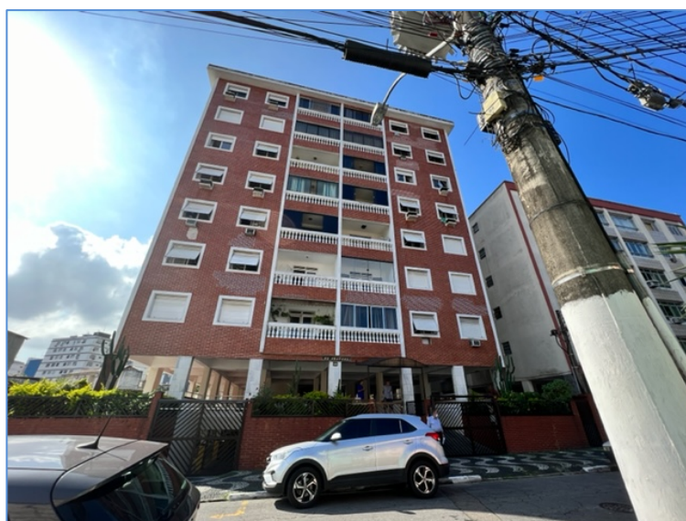
Foto 8 – Vista da fachada do Edifício Aratans
