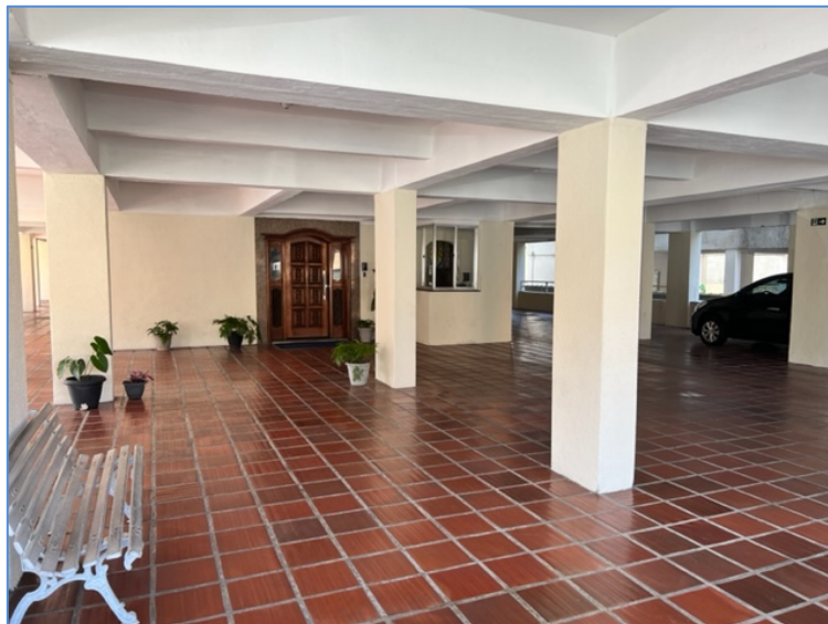
Foto 7 – Vista do hall de entrada e garagem do térreo
